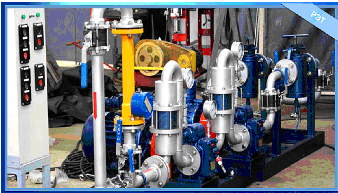
Рисунок 1.7 - Промышленная установка для приготовления водотопливных эмульсий
