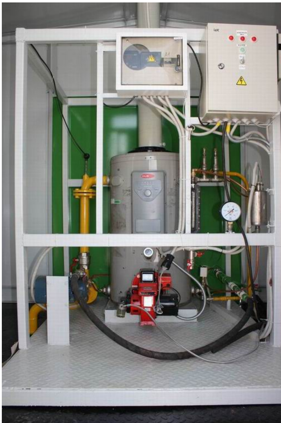
Рисунок 1.7 - Обвязка систем парового котла ППУ
